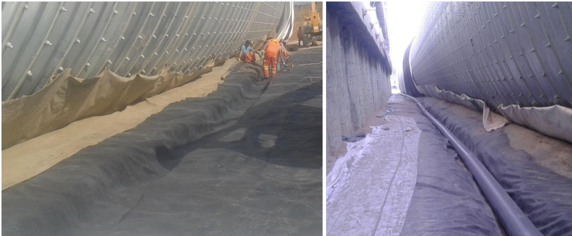
Figure 9. Tuyau de drainage le long du tunnel
