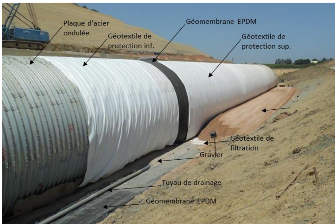
Figure 17. Différents éléments du chantier
