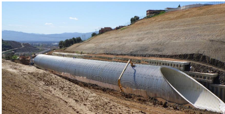
Figure 14. Structure en acier ondulé mise en place
