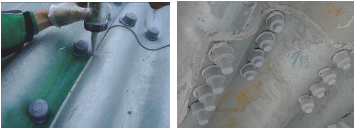
Figure 7. Chevauchements des plaques d'acier et des bouchons remplis de mastic en polyuréthane
